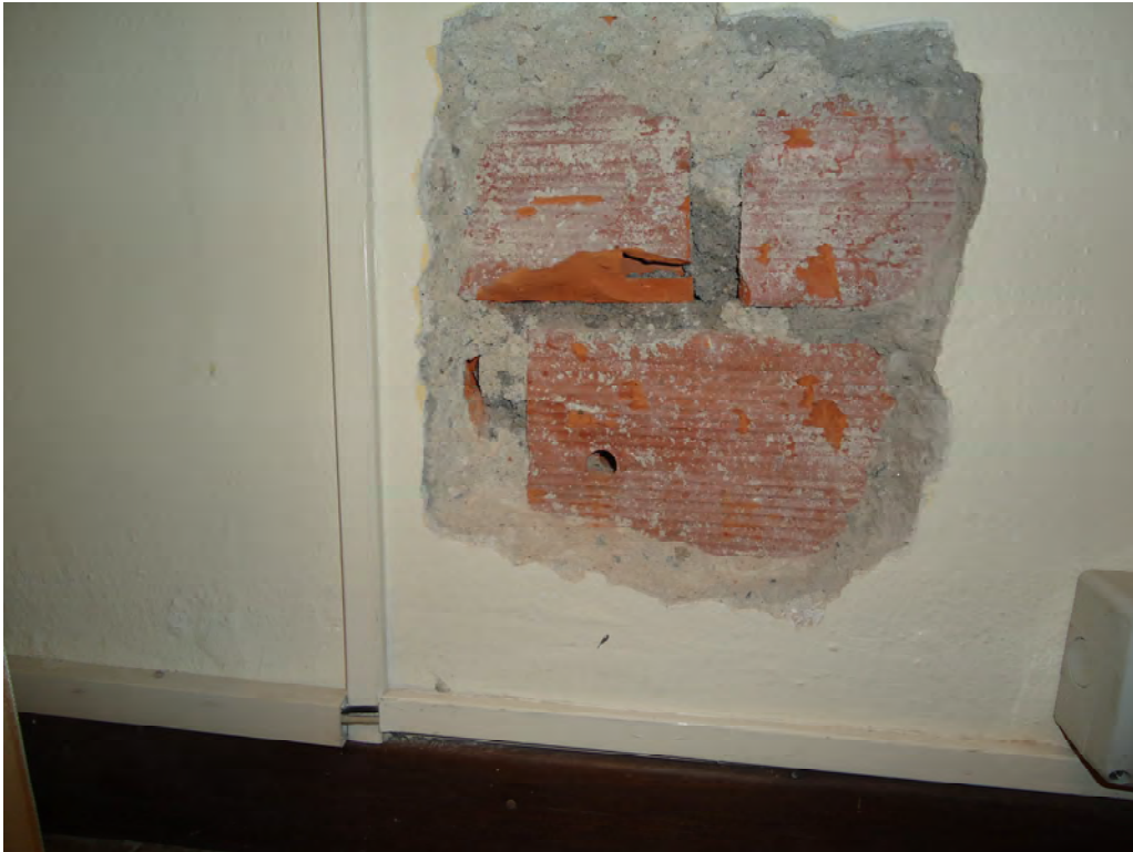
Muratura portante in blocchi laterizi
