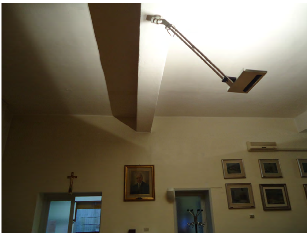
Vista della trave ribassata in copertura del piano terra nella sala Consiliare
