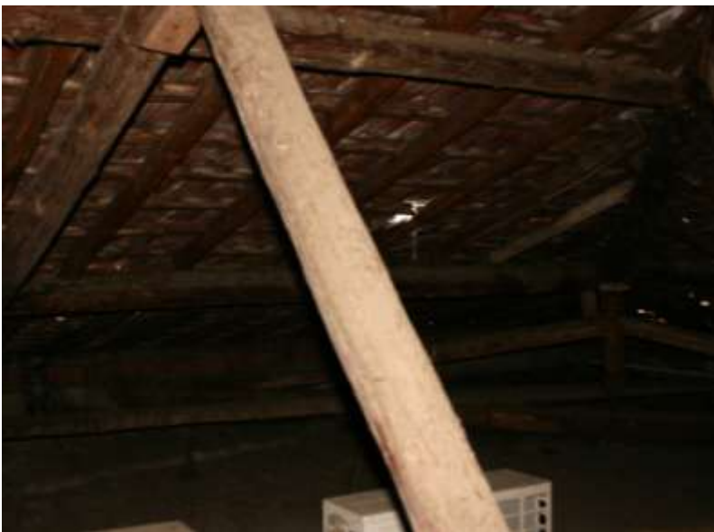
Ammaloramento della struttura in copertura.
