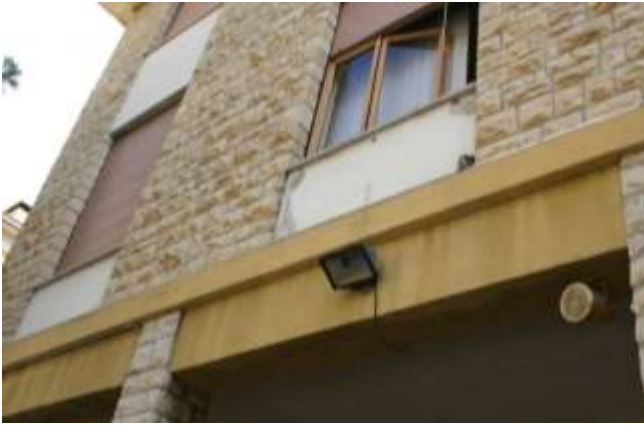
Elementi di degrado e fessurazioni in facciata.
